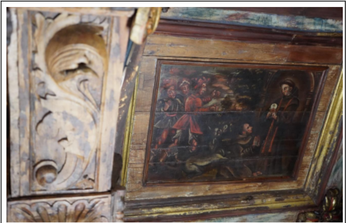
Legenda: Painéis da Capela-Mor restaurados Autoria: Francielle Ferreira Data: 19/06/2024
